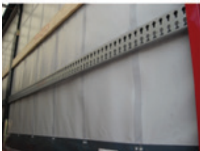
Figuur 27: Aluminium lat met gaten voor stuwbalken
