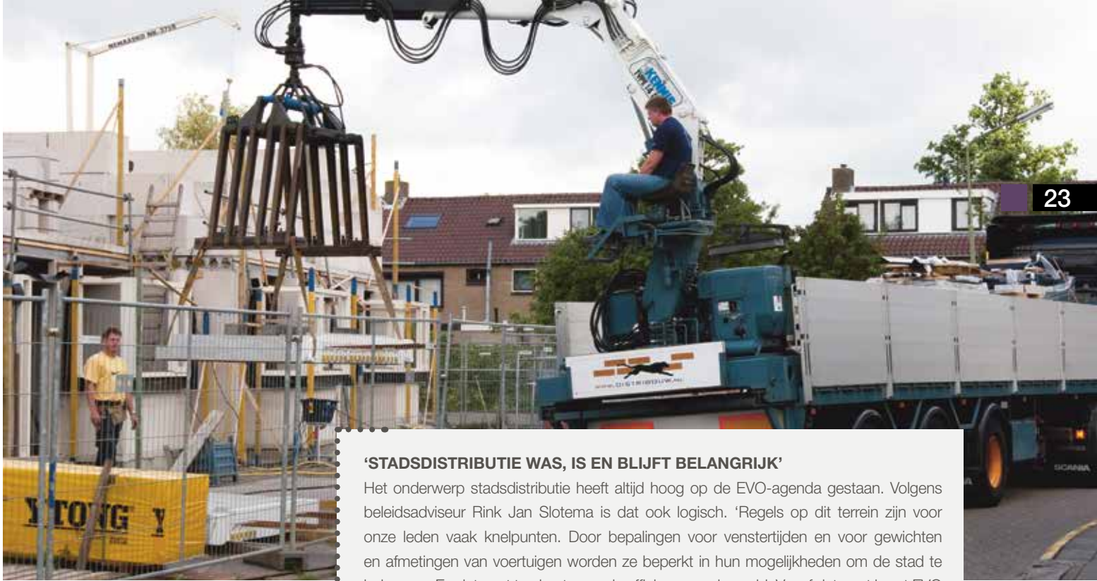
Bouwplaatsen krijgen vele leveringen per dag.
